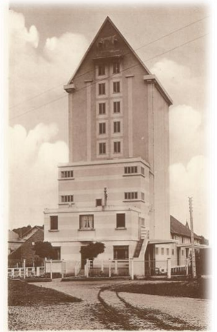
SAINT-VALÉRIEN (Yonne) — Le Silo
