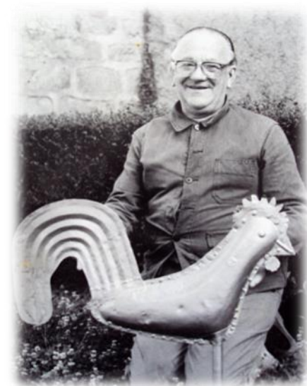
1984 06 Pierre CHEVALIER avec le coq du clocher. Au cours des travaux de réfection de l'église et du clocher
